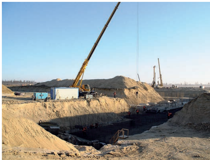
На космодроме в Амурской области закладывают фундаменты стартового и технического комплексов. Космодром Восточный строят почти 3000 человек. На стройплощадках они работают в круглосуточном режиме.
